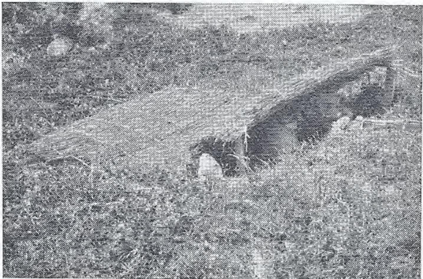
Sl. 95 — Pokrivanje streljačkog zaklona asurom (preko asure nasipa se zemlja za zaštitu od topotnog dejstva)
